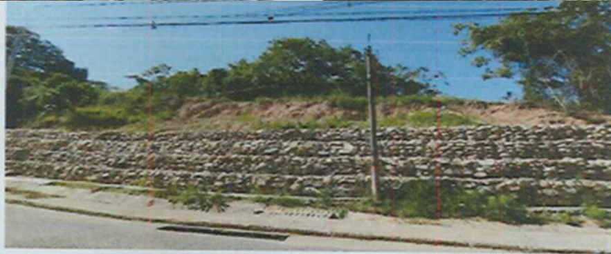
Imagen tomada in situ
